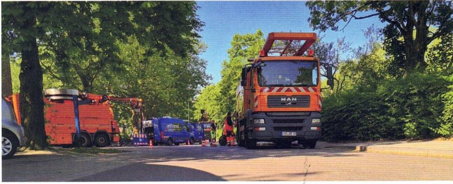
An der Baustelle in Emden war der Einsatz von Wasserhöchstdrucktechnik erfolgreich. | Fotos: IMS Robotics
