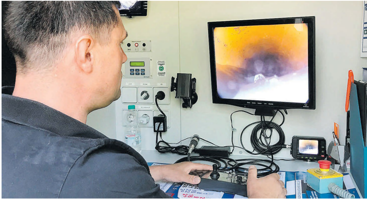
Überwachung: Andrej Netschto am Kontrollschirm. Darauf zu sehen ist das verstopfte Abwassersystem.
